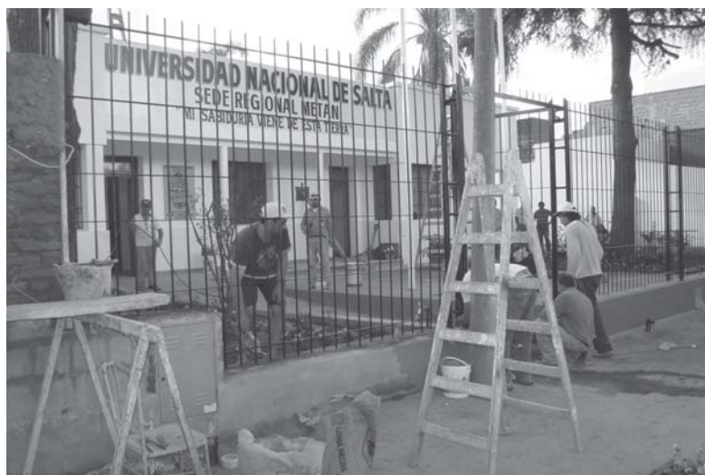
Ultimos detalles de la construcción de la Sede Regional Metan-Rosario de la Frontera, en San José de Metán.
