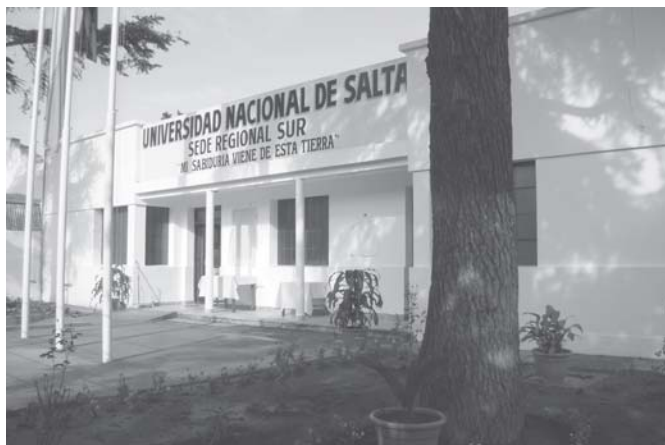
Fachada de la Sede Regional Metán-Rosario de la Frontera, San José de Metán.
