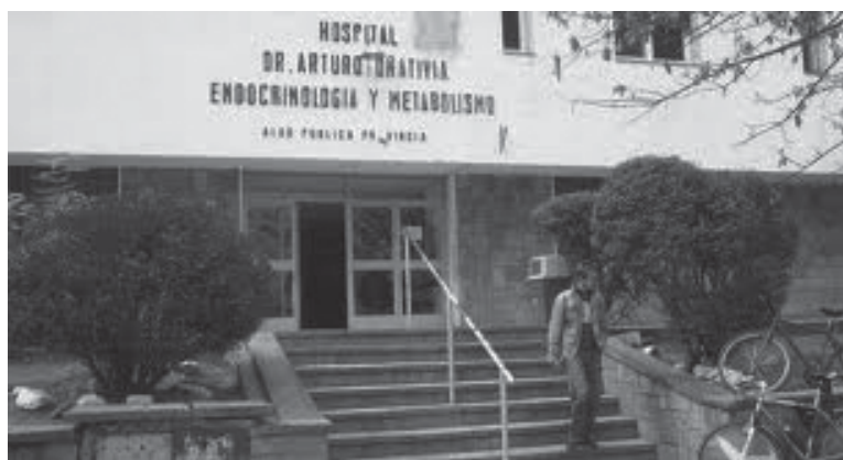
Vista actual de la entrada principal del Hospital Dr. Arturo Oñativia. Foto: www.bureaudesalud.com
